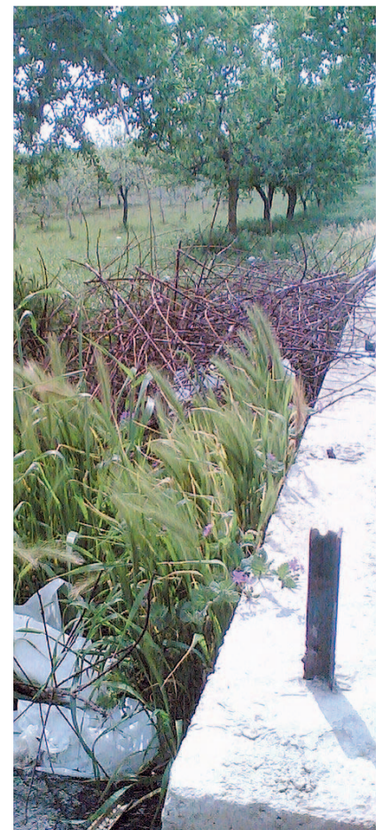
DIVELTA La recinzione del parcheggio
